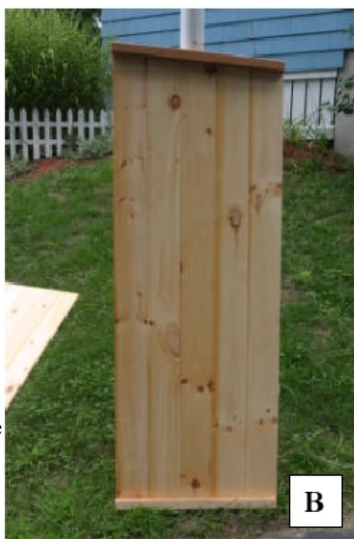
x 38 mm (dimensions réelles). Avec ces tasseaux on a coupé des morceaux assez long pour être fixé au bas du panneau de côté et d'autres avec des coupes en biais pour s'adapter à la pente du bord haut [Photos A, vue extérieur, B, vue intérieur et l'Annexe Figure 1]. Cela a été répétée (en miroir) pour le deuxième panneau de côté.
